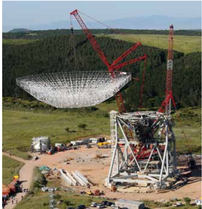
Montagearbeiten am Radioteleskop auf Sardinien
